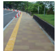
ブロック舗装
